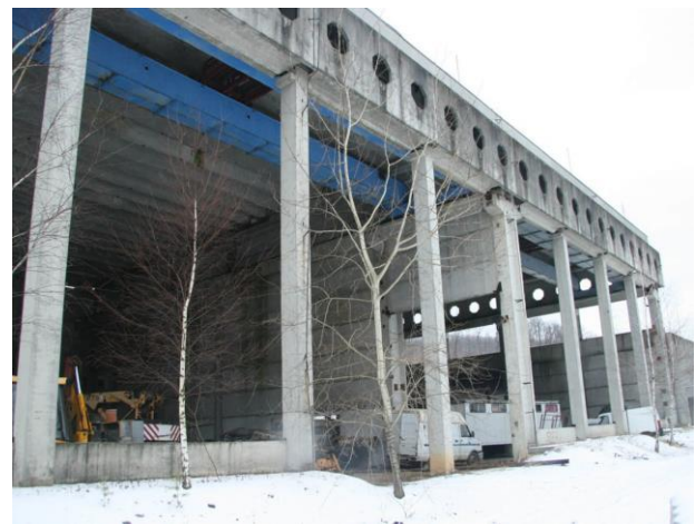
6. ábra: A használt akkumulátorfeldolgozó felújítás alatt, 2010 (fotó: Magyar Balázs)
